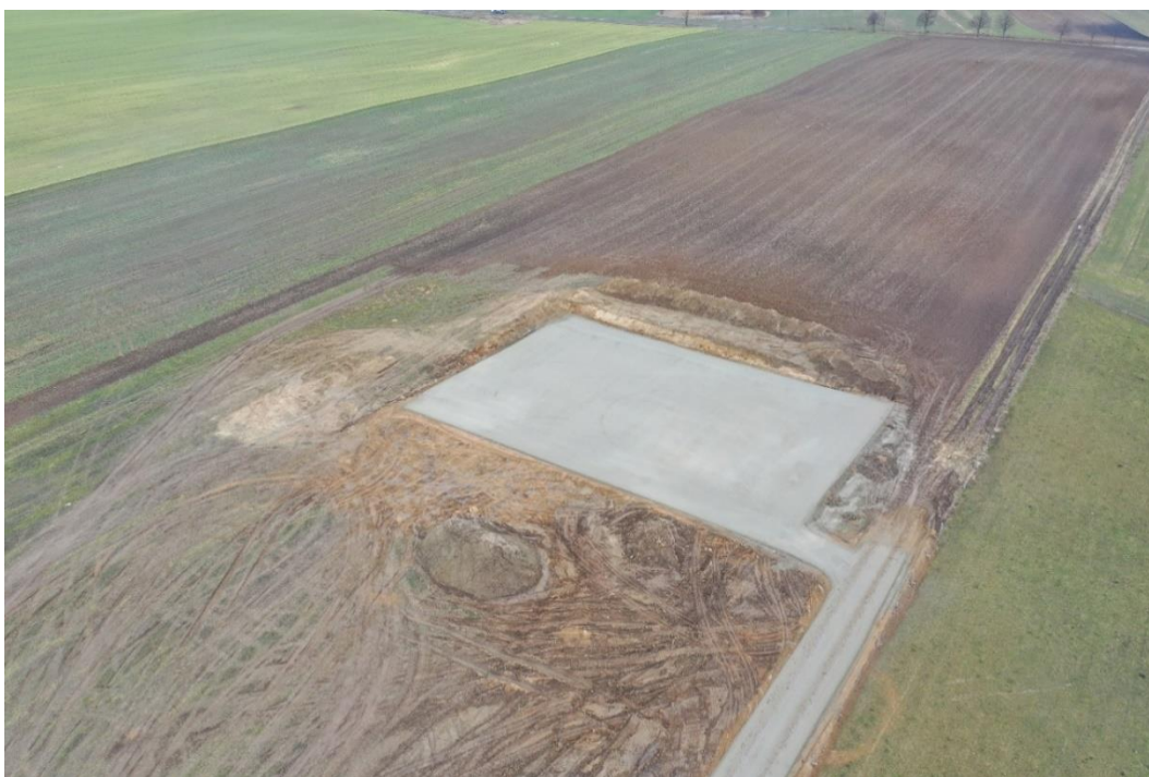
Zdjęcie 13. Budowa farmy wiatrowej Nowy Klukom – Krzęcin Źródło: Anna Kozłowska
