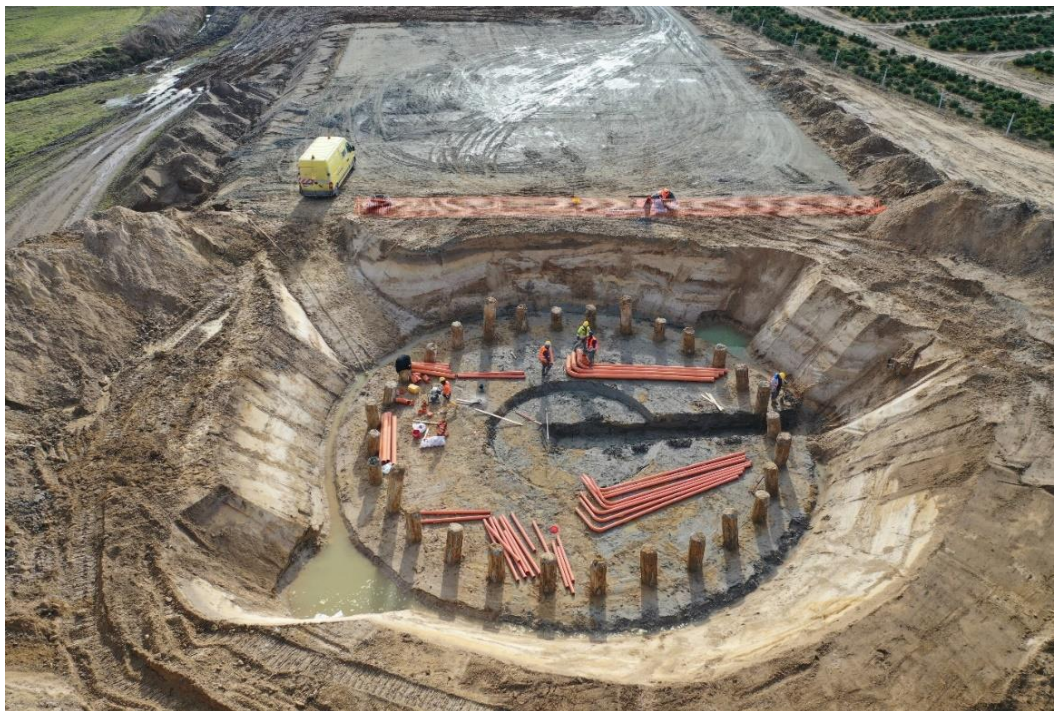
Zdjęcie 10. Budowa farmy wiatrowej Nowy Klukom – Krzęcin Źródło: Anna Kozłowska
