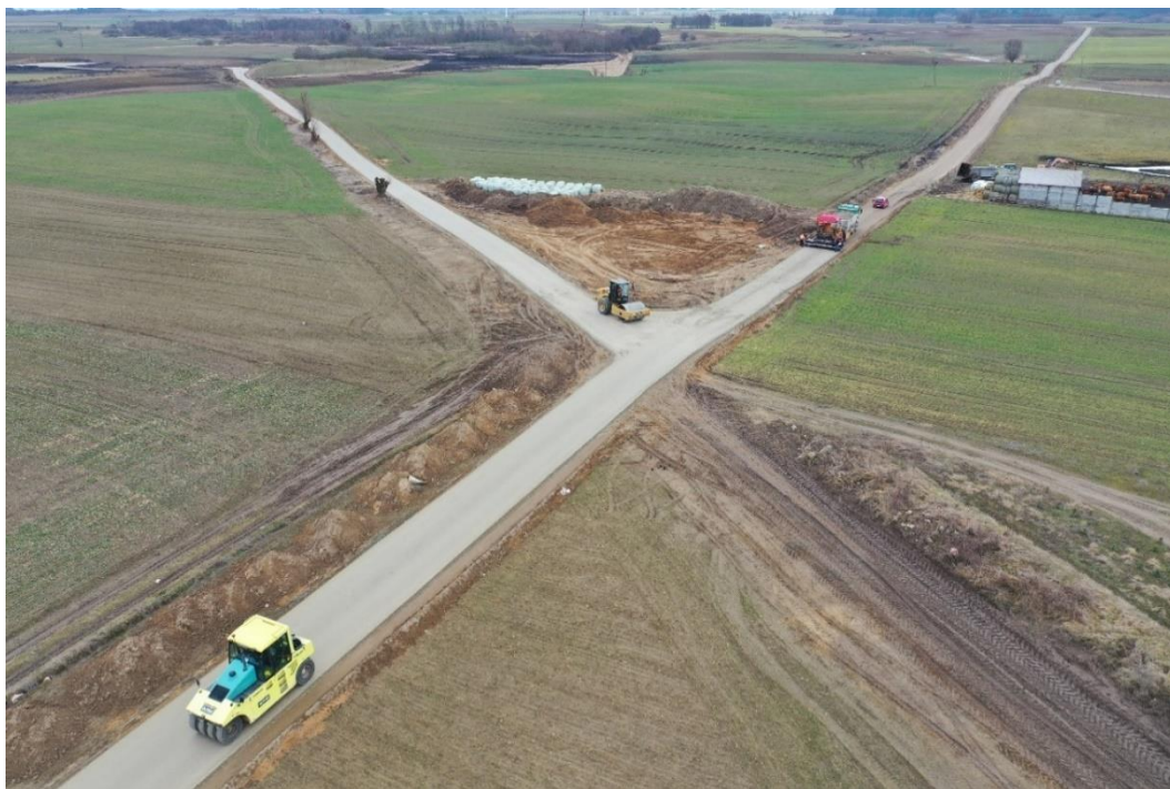
Zdjęcie 11. Budowa farmy wiatrowej Nowy Klukom – Krzęcin Źródło: Anna Kozłowska
