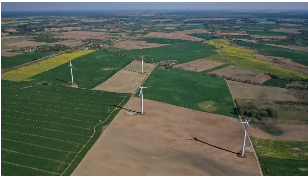
Zdjęcie 12. Budowa farmy wiatrowej Nowy Klukom – Krzęcin Źródło: Anna Kozłowska
