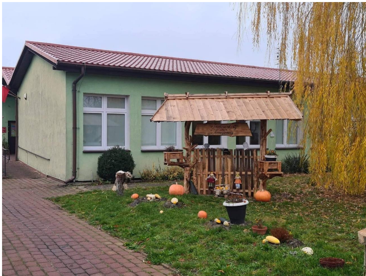
Zdjęcie 15: Budynek Środowiskowego Domu Samopomocy Źródło: Opracowanie własne
