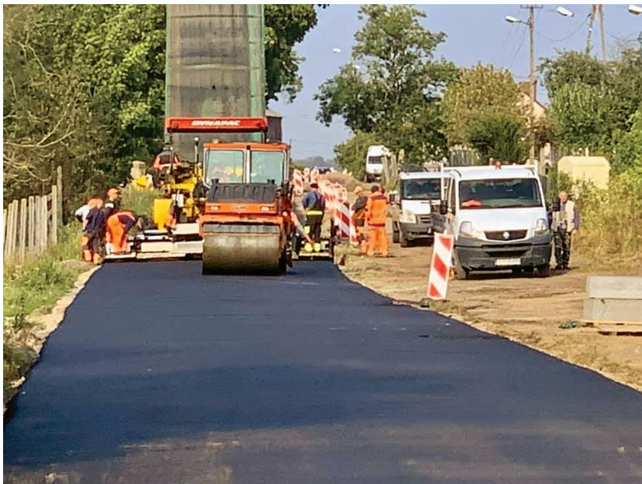
Zdjęcie 3: Przebudowa ulicy Zakładowej w Granowie została sfinansowana ze środków z Rządowego Funduszu Inwestycji Lokalnych 1.243.725 zł, w tym 1.025.500 zł to kwota przyznana w ramach naboru dla gmin popegeerowskich.
