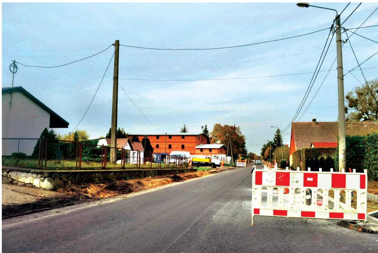
Zdjęcie 4: Nowych chodników oraz nowej nawierzchni bitumicznej na drodze wojewódzkiej nr 160 doczekali się także mieszkańcy Kaszewa.
