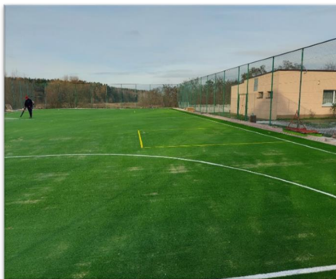
Zdjęcie 5: Boisko wielofunkcyjne w Mielęcinie Źródło: Opracowanie własne
