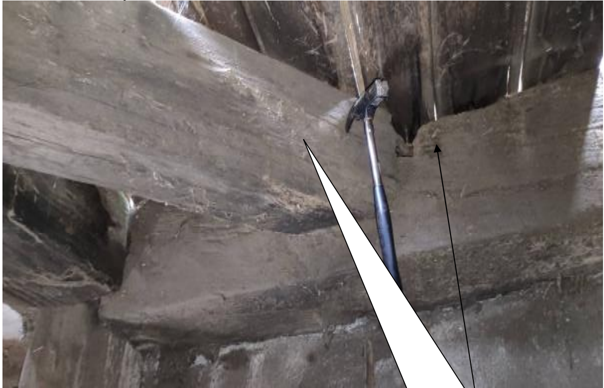
Drewniana konstrukcja nośna ścian
