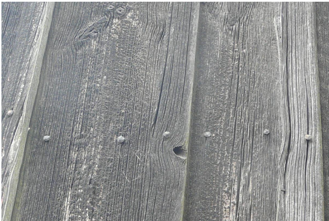
Fragment deskowania z nabitými listwami i kutými gwoździami.
