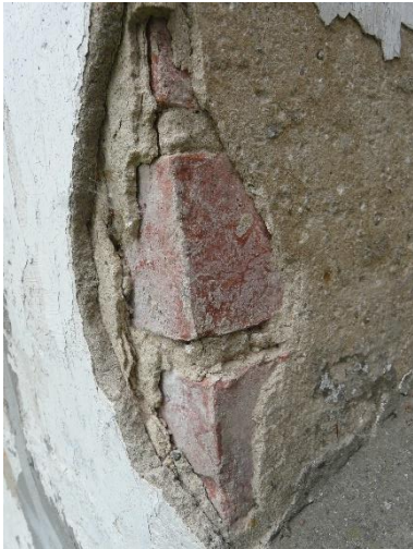
Fragment historycznego tynku pod warstwą wtórnej zaprawy.
