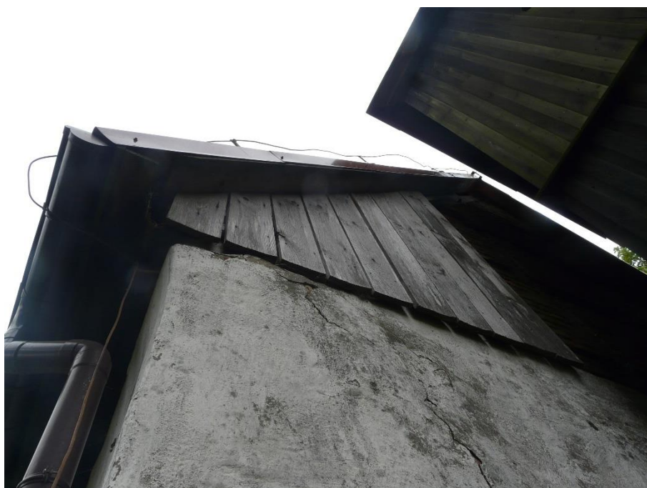
Deskowanie elewacji wschodniej. Powierzchnia desek wypłukana.
