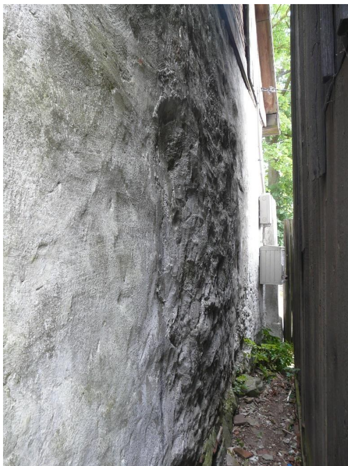
Elewacja zachodnia. Ślady po dawnej wieży.
