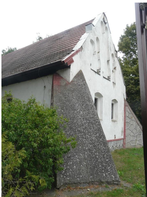
Narożnik północno- wschodni. Spękana szkarpa pokryta porostami.
