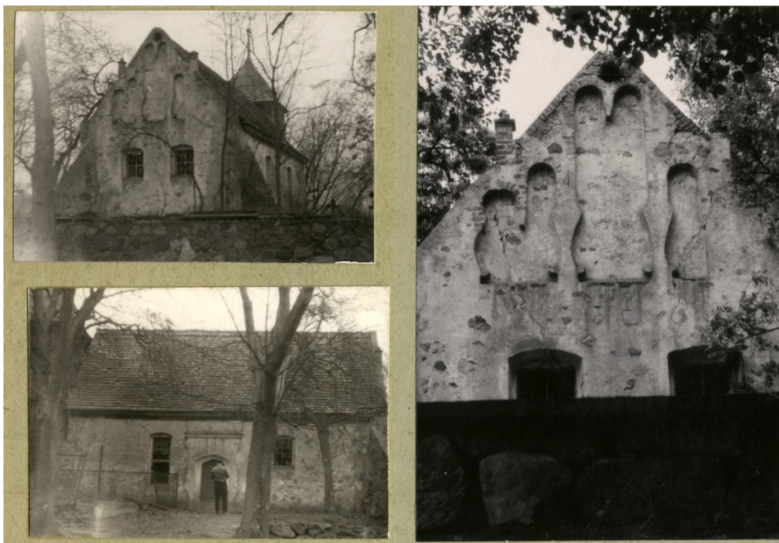
II. 2. Zającia kościoła z 1960 r. Zwraca uwagę inna wyprawa tynkowa – cieńsza i nie pokrywająca wystających z muru kamieni. Zdjęcie pochodzi z „zielonej karty”
