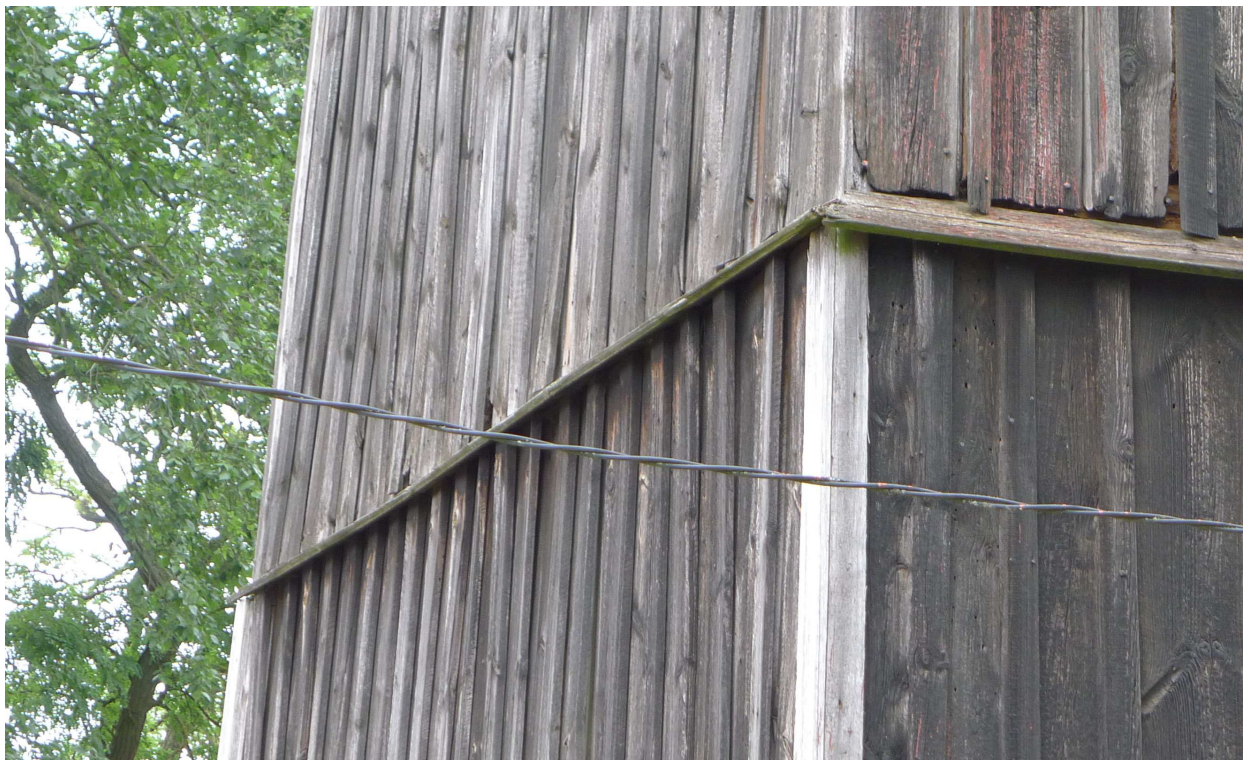
Narożnik pd-zach -gzyms pośredni – deska okapowa, poszycie cisowe, narożnik modrzewiowy
