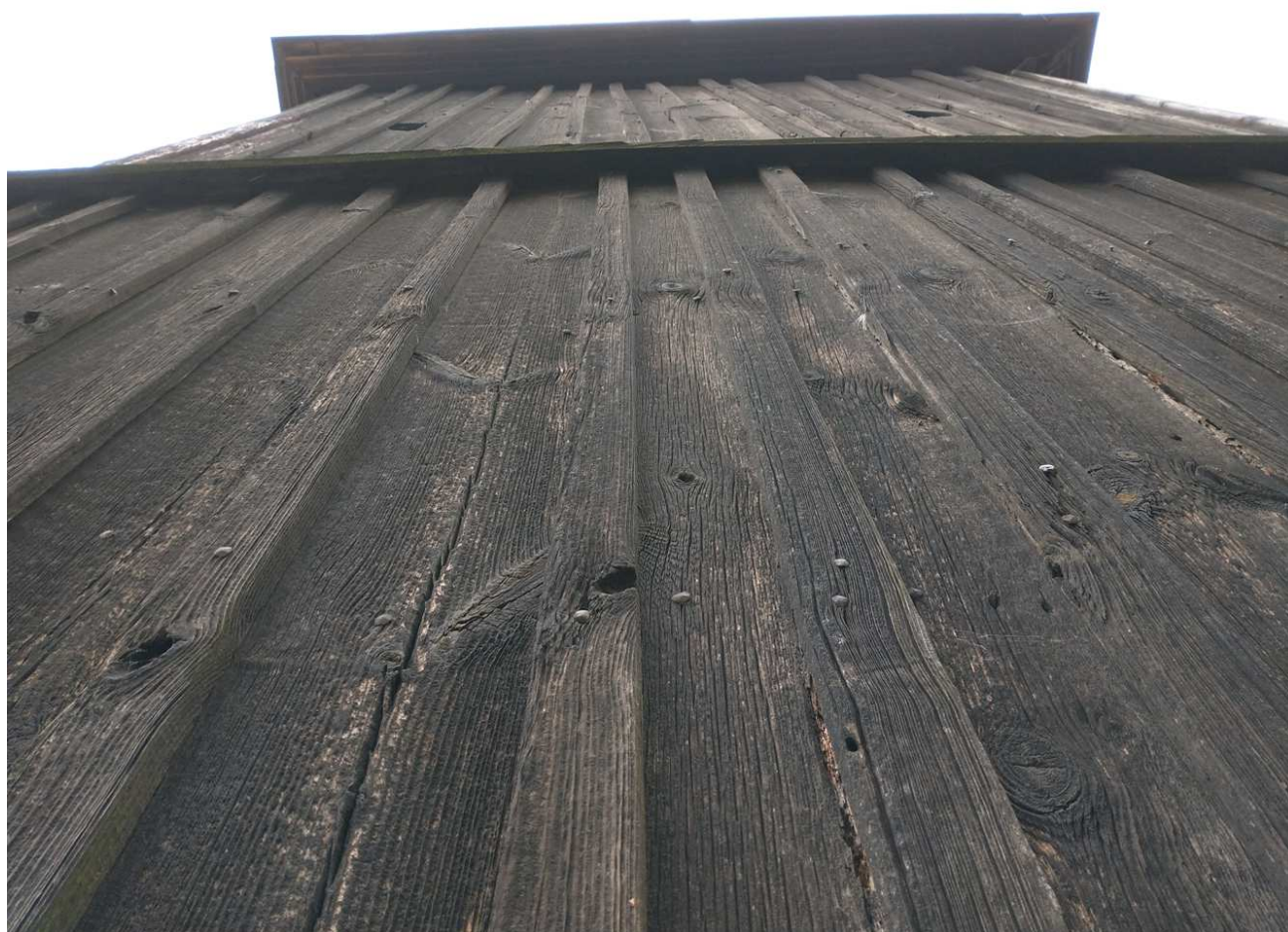
Cisowe poszycie elewacji południowej łączone na gwoździe kute, widoczna wyraźna struktura drewna
