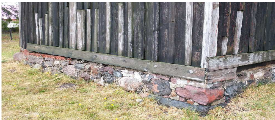
Narożnik południowo-zachodni podmurówki
