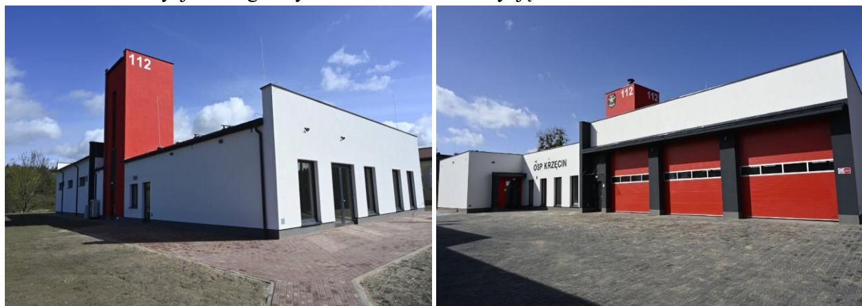
Zdjęcia III. 3 i 4. Budowa Remizy Osp w Krzęcinie. Opracowanie własne.
