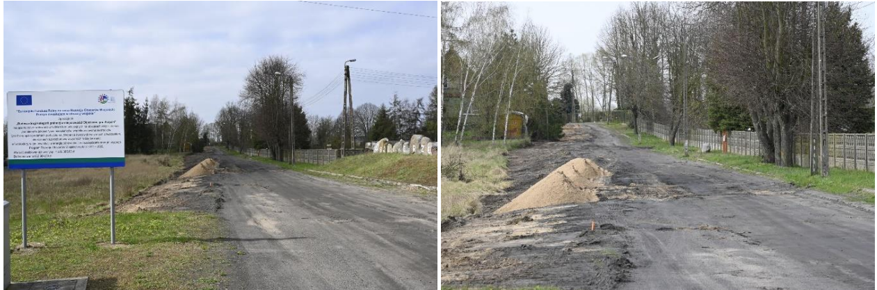
Zdjęcia III. 9 i 10. Przebudowa drogi w Objezierzu. Opracowanie własne.
