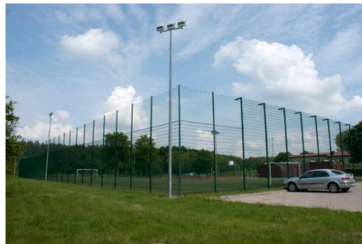
Zdjęcia III. 15. Orlik w Krzęcinie po modernizacji. Opracowanie własne.
