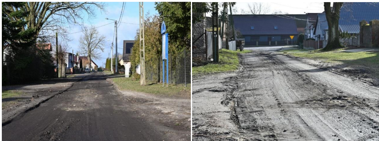
Zdjęcia III. 7 i 8. Przebudowa drogi w Żeńsku. Opracowanie własne.
