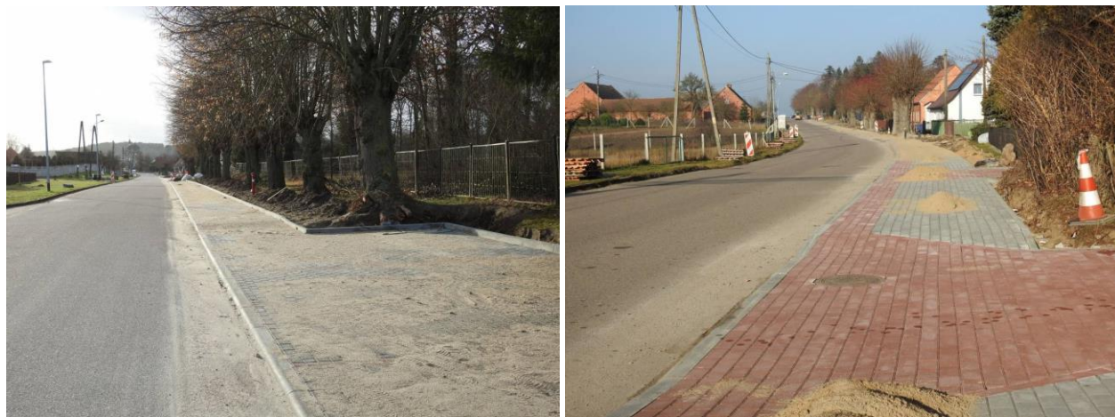
Zdjęcia III. 1 i 2. Budowa Chodników w Chłopowie. Opracowanie własne.
