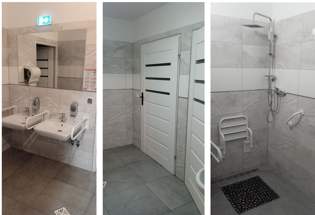
Zdjęcie XVII. 7,8 i 9; Remont pomieszczeń sanitarnych w ŚDS. Źródło: opracowanie własne
