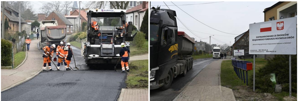
Zdjęcia III. 11 i 12. Przebudowa drogi w Żeńsku. Opracowanie własne.
